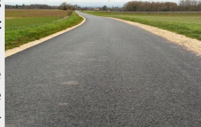
L'opération de rénovation a consisté en un rabotage des ancrages de chaussée, une mise en œuvre d'enrobé noir et un rechargement des accotements en grave non traitée sur une largeur de 0,5 à 1 m.
